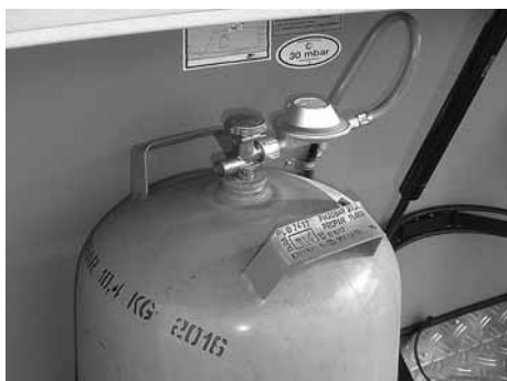
Afb. 108: gasfles met drukverminderingssklep
