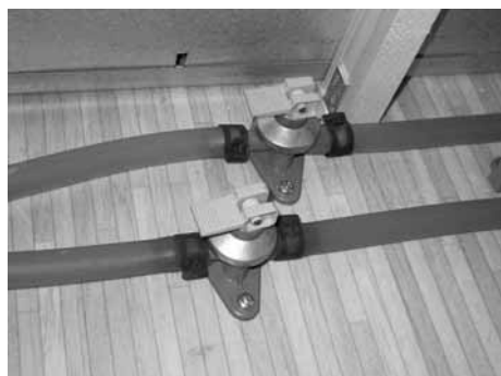
Afb. 101: Aftapkranen gesloten
