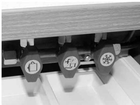
Afb. 77: Snelsluitkranen
