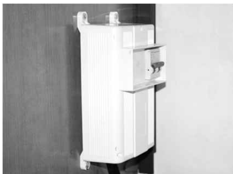
Afb. 69: Hoofdschakelaar (FI-contactverbreker)
