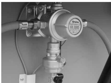
Afb. 109: Gasvoorziening DuoControl CS
