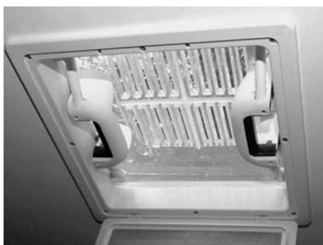
Afb. 117: Dakluik in de sanitaire zone
